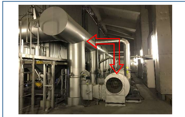
排ガス冷却装置
