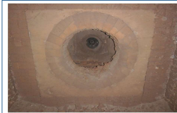
再燃焼炉の内部
