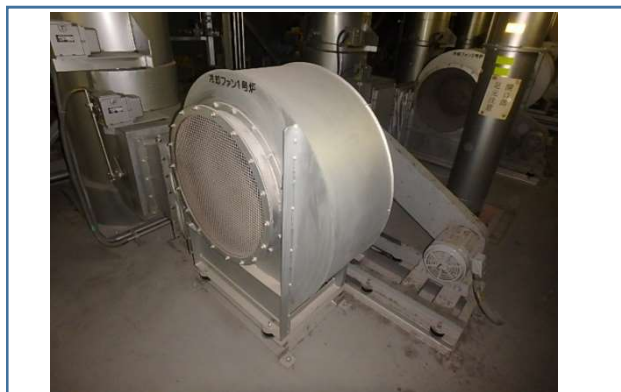
冷却用空気送風機
