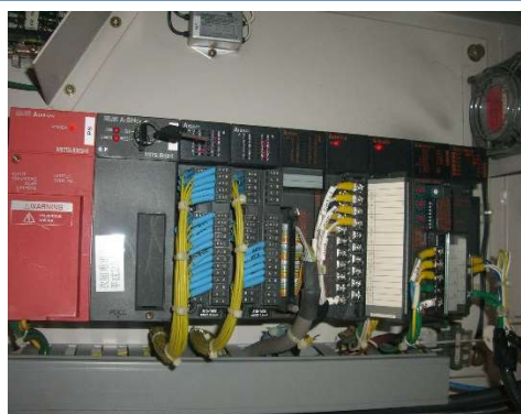
シーケンサー（制御盤内）
